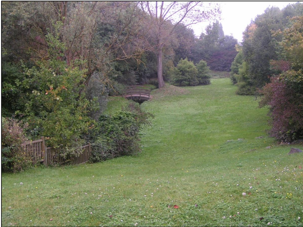
Figure 25 : Bassin servant de parc lorsqu'il est à sec
