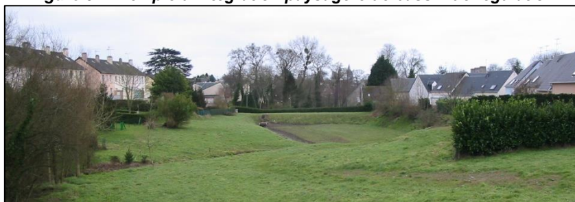
Figure 5 : Exemple d'intégration paysagère de bassin de régulation
